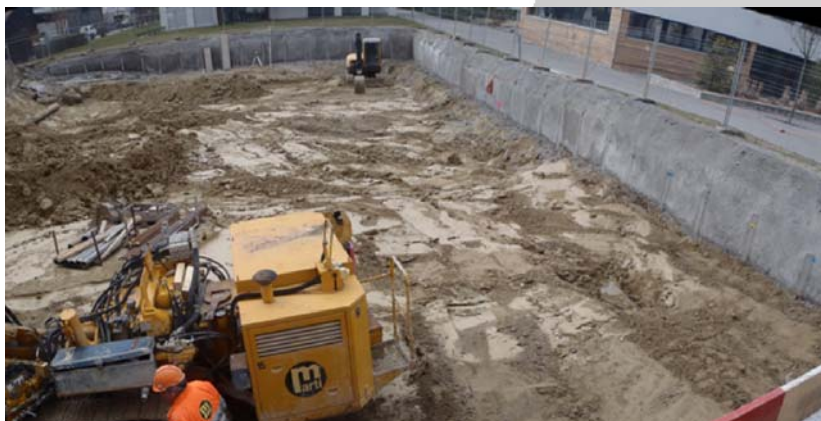
Début des excavations et du soutènement
