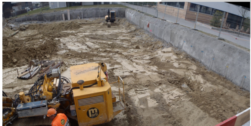
Beginn des Aushubs und Baugrubensicherung
