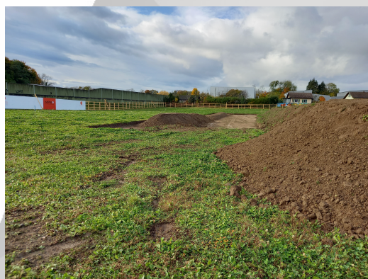
Lagerung von Erdmaterial
