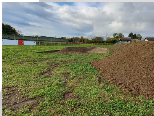
Stockage de matériaux terreux
