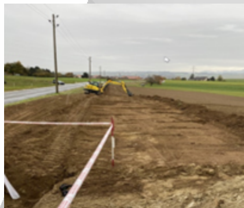
Suivi des travaux, phase de remblayage
