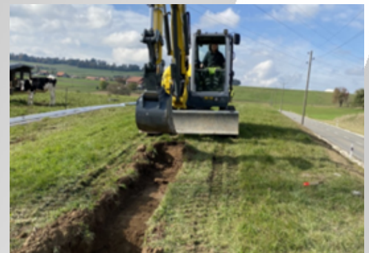
Suivi des excavations
